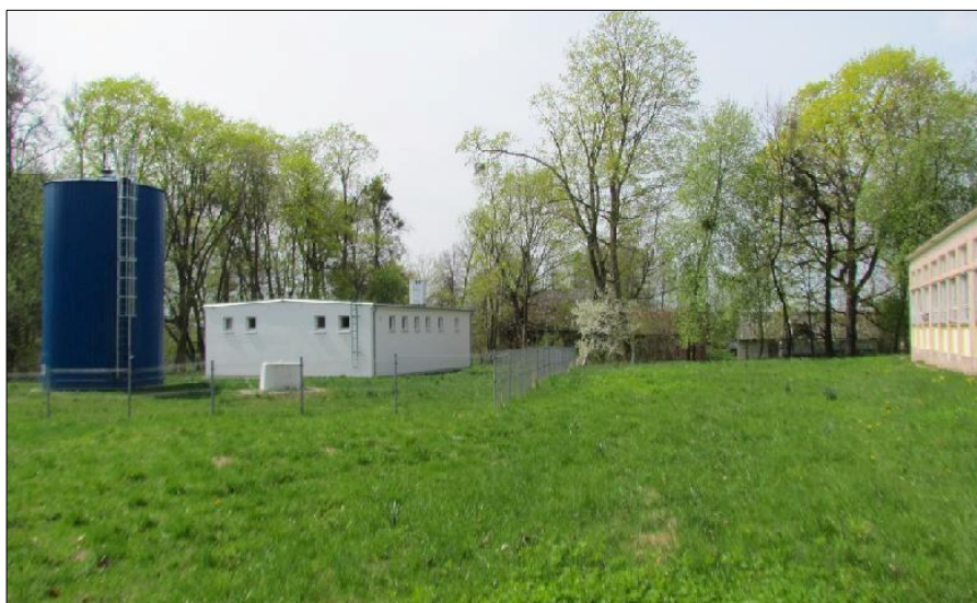
Rys. III.12. Miejsce montażu masztu
