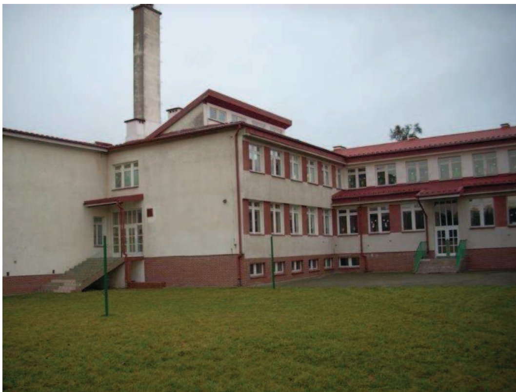
Widok od strony boiska strona południowa
