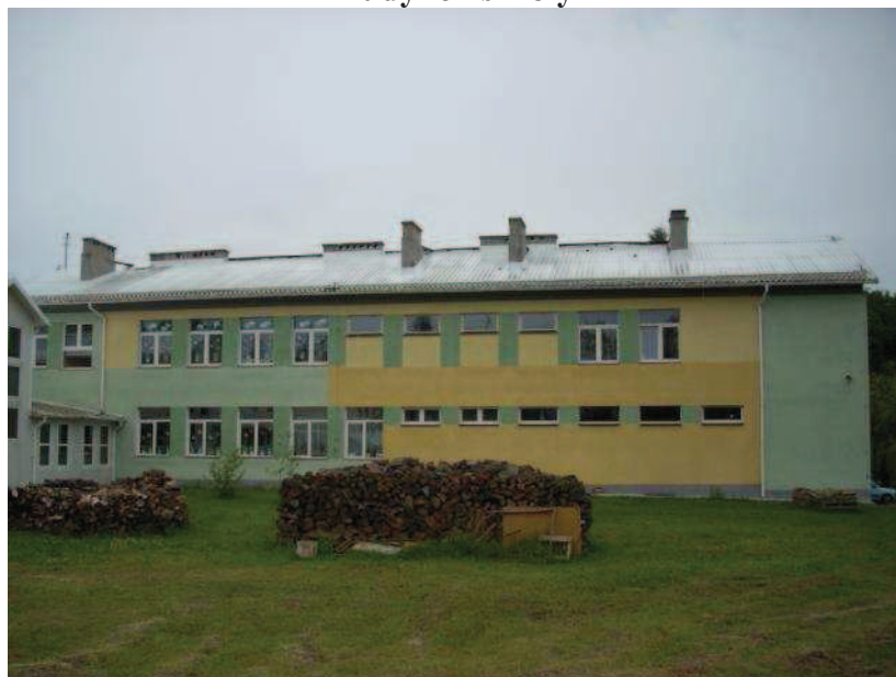
Widok budynku szkoły od strony północnej
