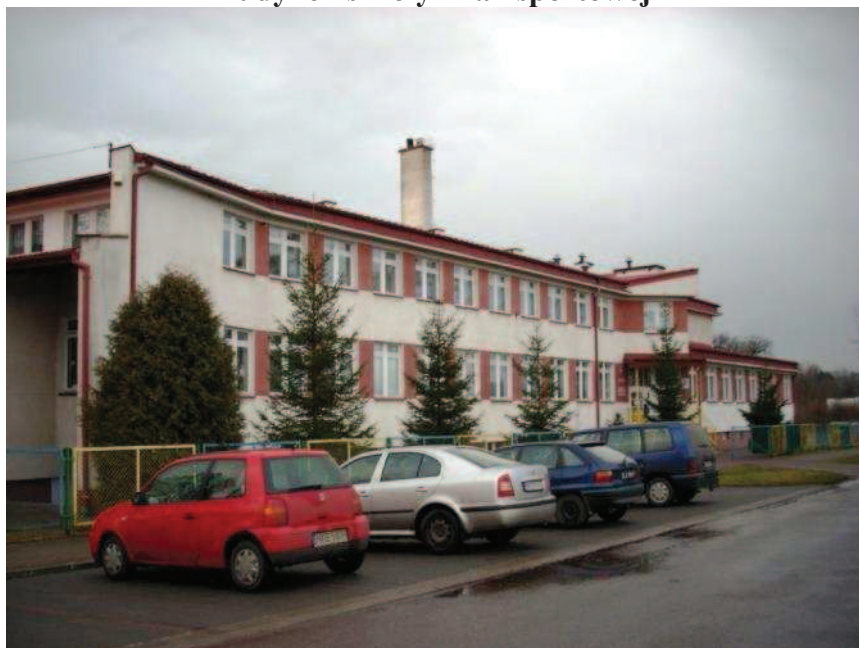
Widok od strony północnej
