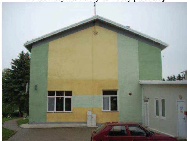
Widok budynku szkoły od strony wschodniej
