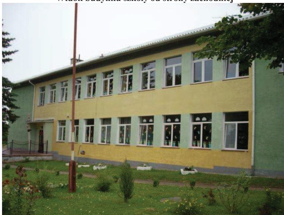
Widok budynku szkoły od strony południowej
