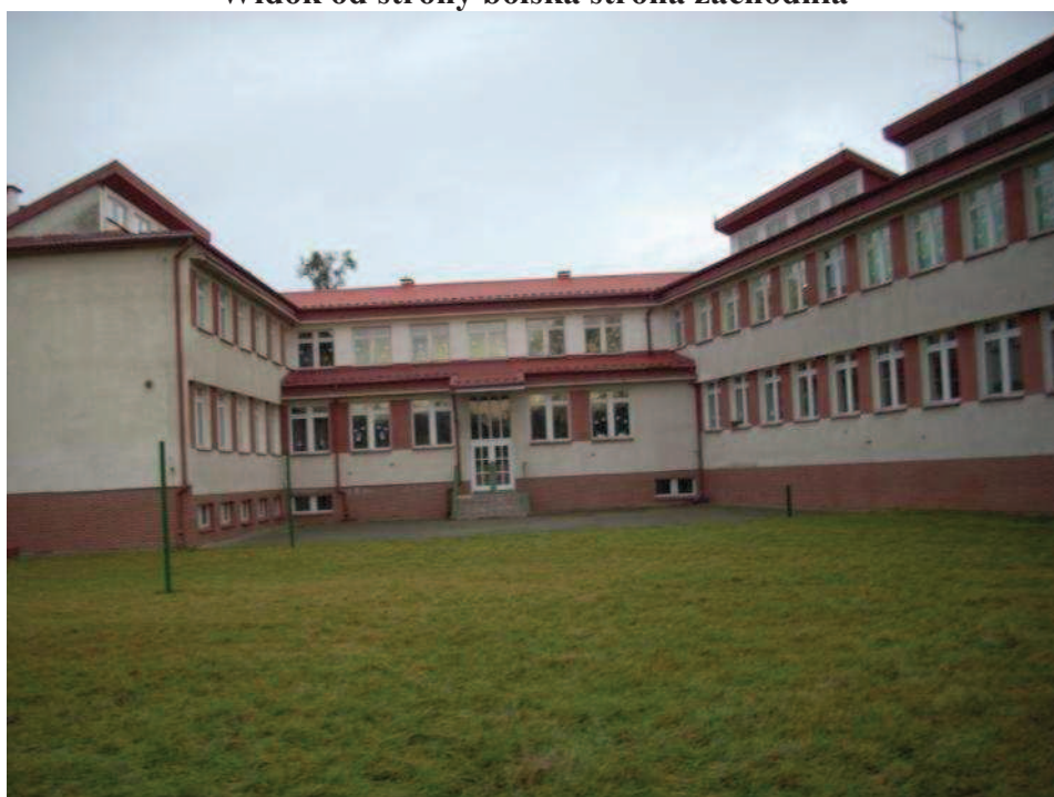
Widok od strony boiska strona południowa
