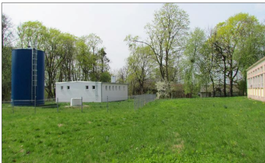
Rys. III.12. Miejsce montażu masztu
