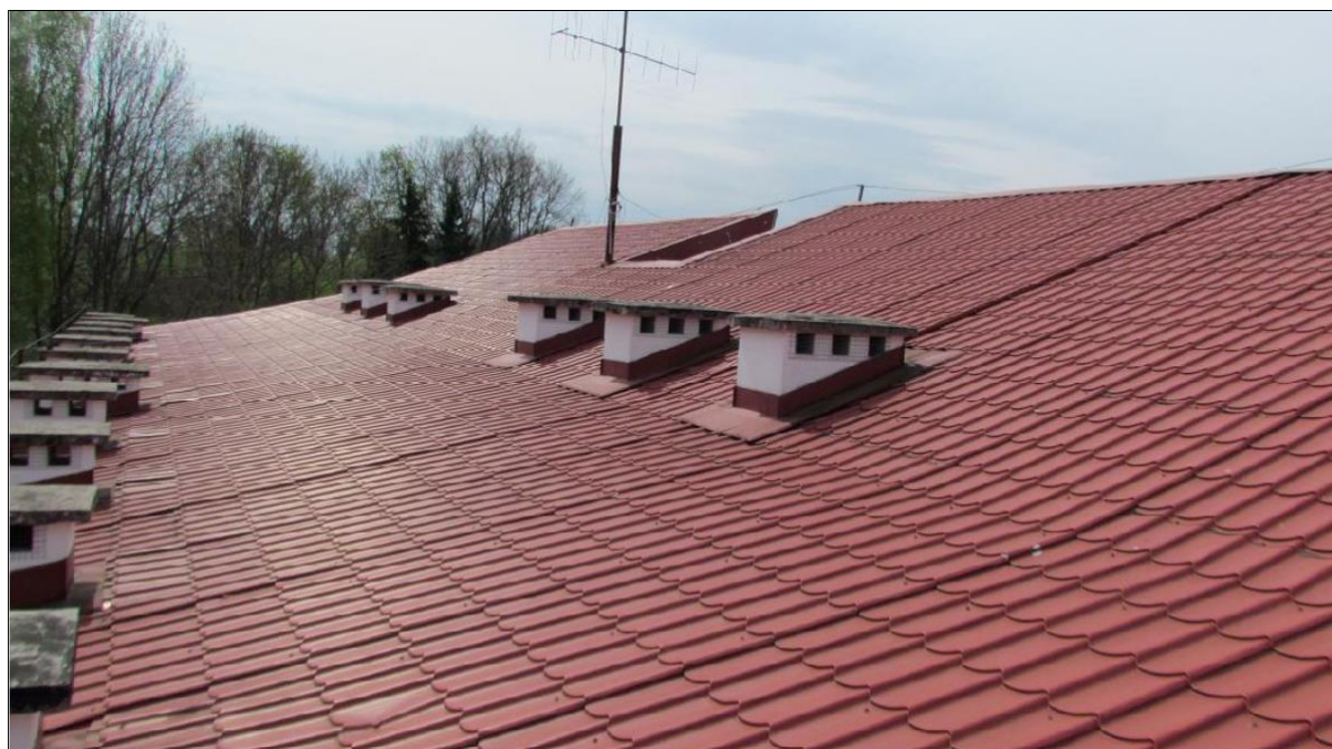
Rys. III.13. Miejsce montażu masztu na dachu
