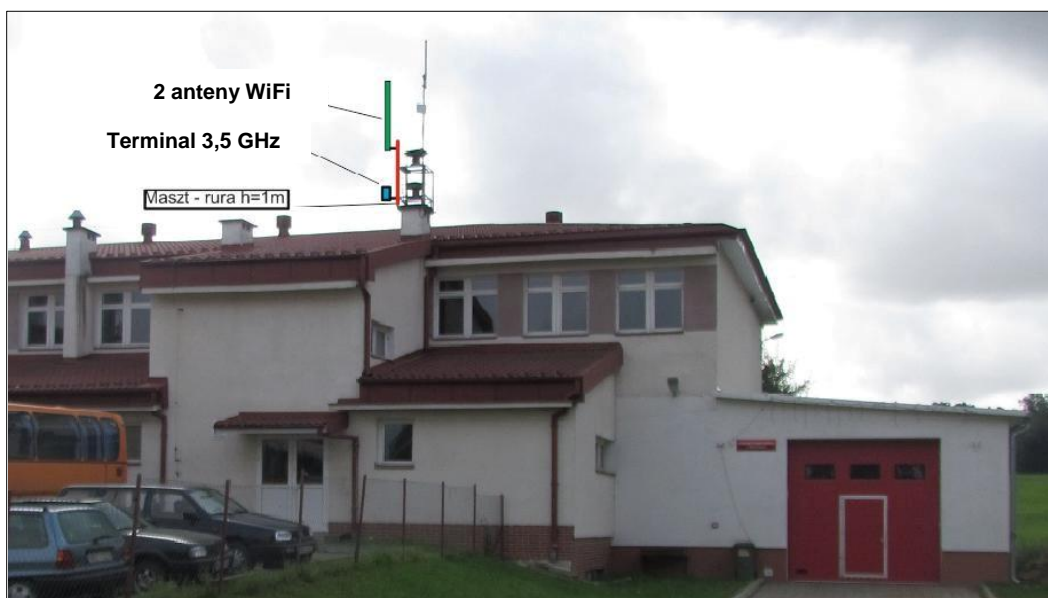
Rys. III.25. Projekt masztu wraz z antenami
