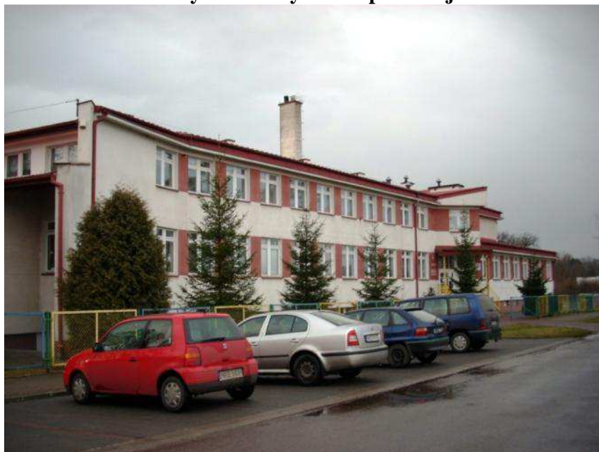
Widok od strony północnej
