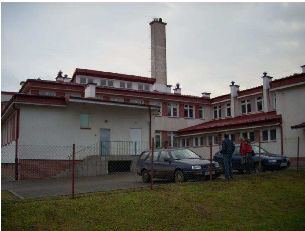
Widok od strony zachodniej
