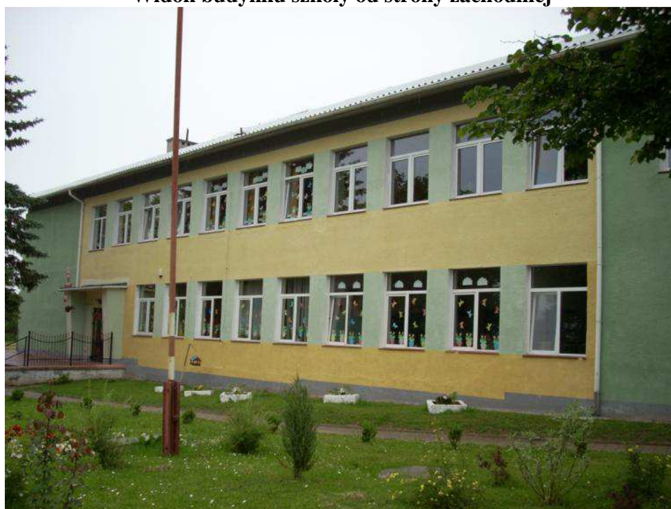
Widok budynku szkoły od strony południowej
