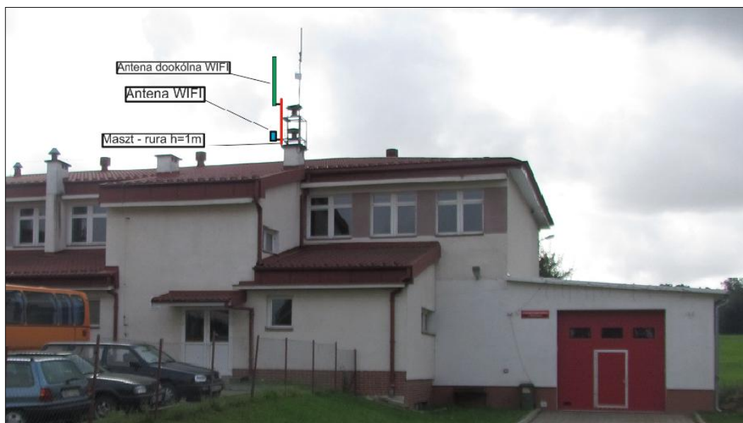
Rys. III.25. Projekt masztu wraz z antenami
