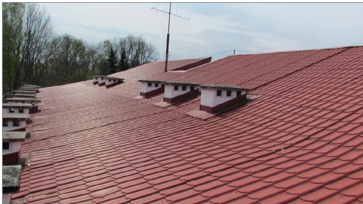
Rys. III.13. Miejsce montażu masztu na dachu
