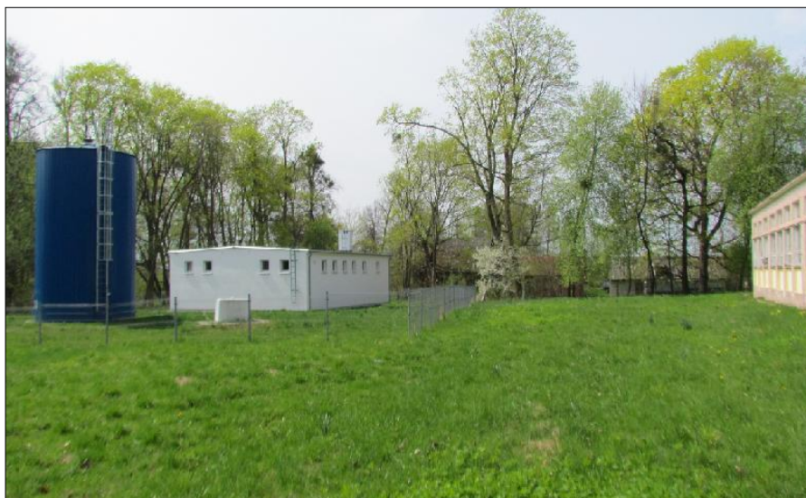
Rys. III.12. Miejsce montażu masztu
