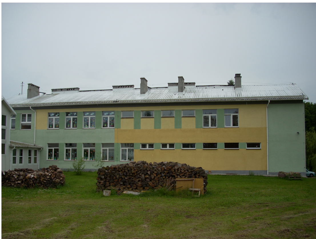
Widok budynku szkoły od strony północnej
