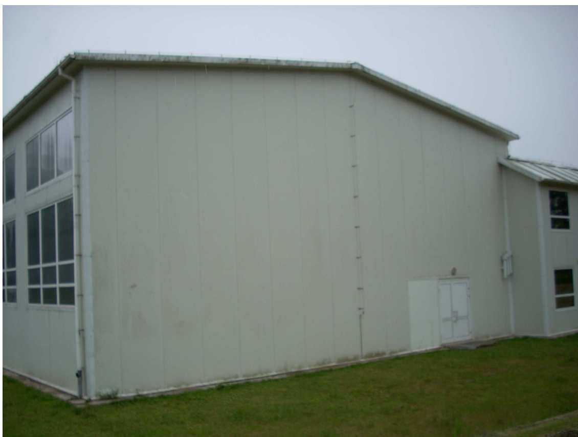
Widok hali sportowej od strony północnej
