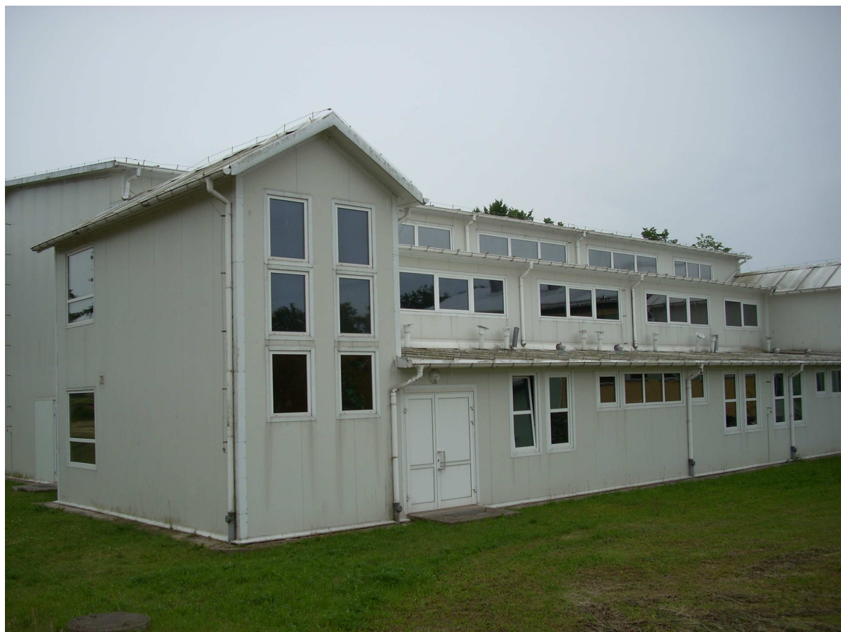
Widok hali sportowej od strony zachodniej
