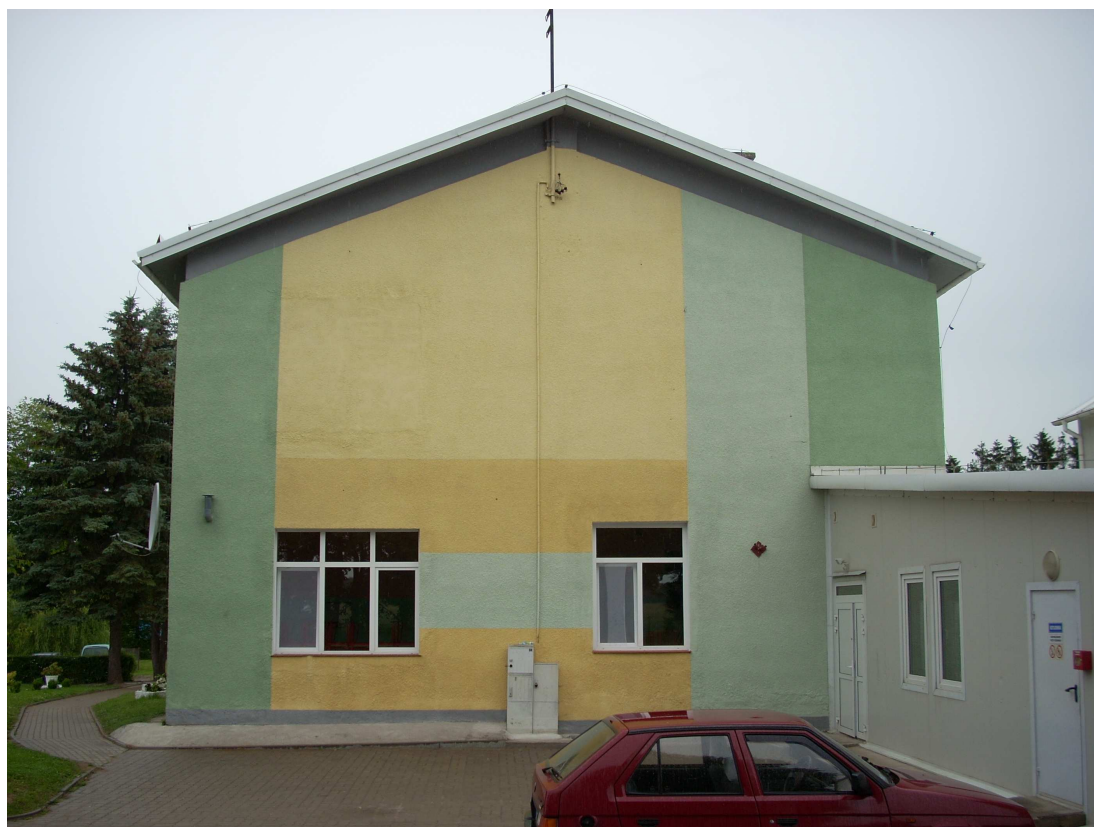
Widok budynku szkoły od strony wschodniej
