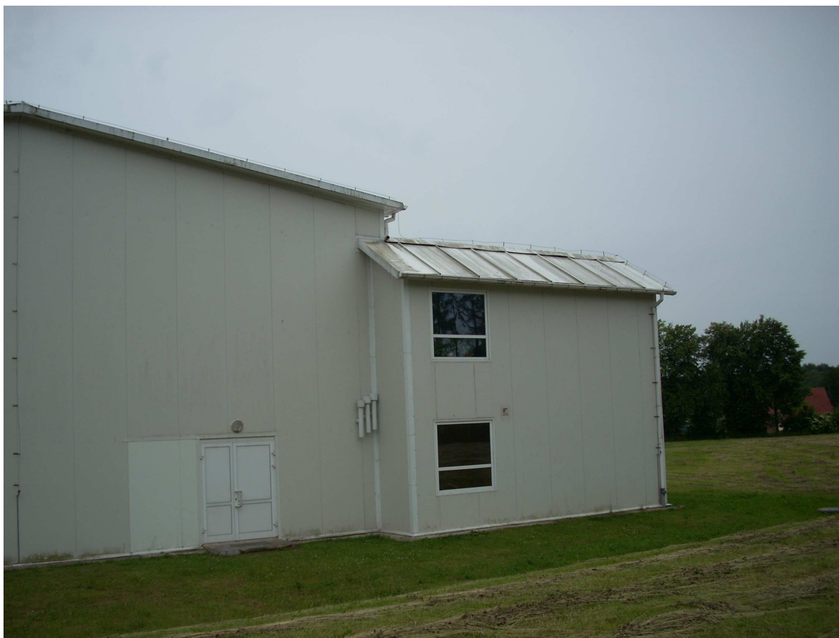
Widok klatki schodowej hali sportowej od strony północnej
