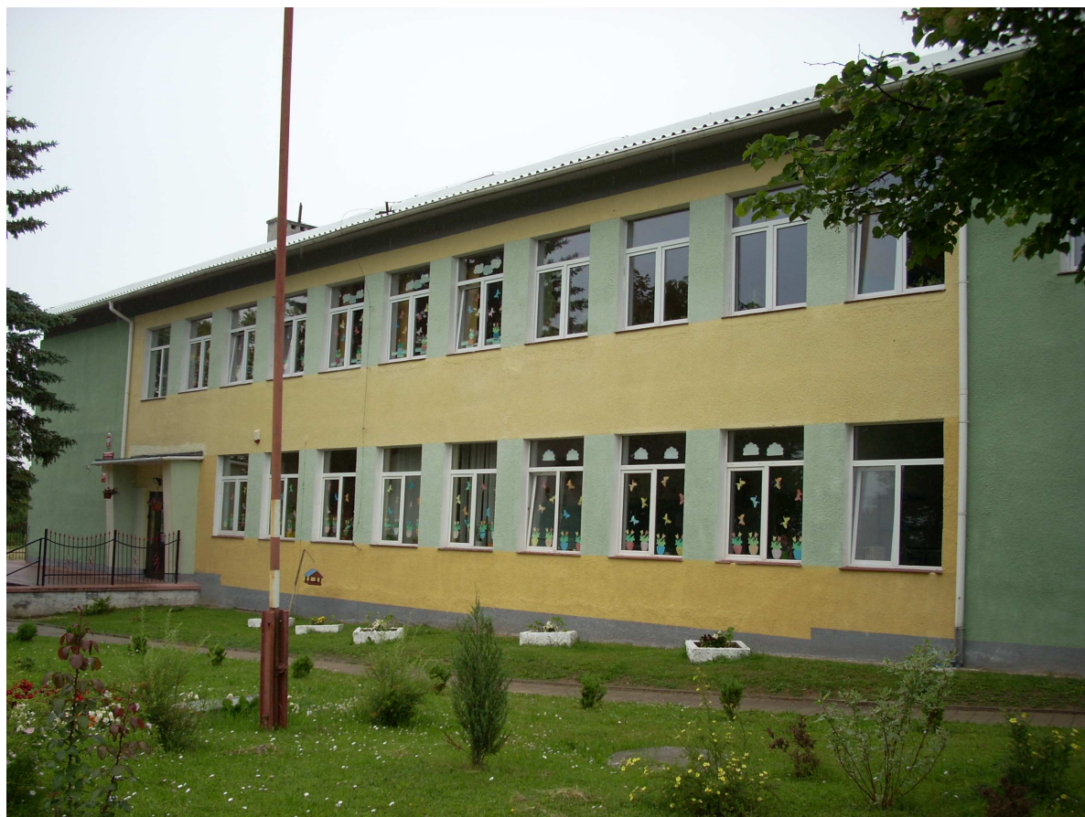
Widok budynku szkoły od strony południowej
