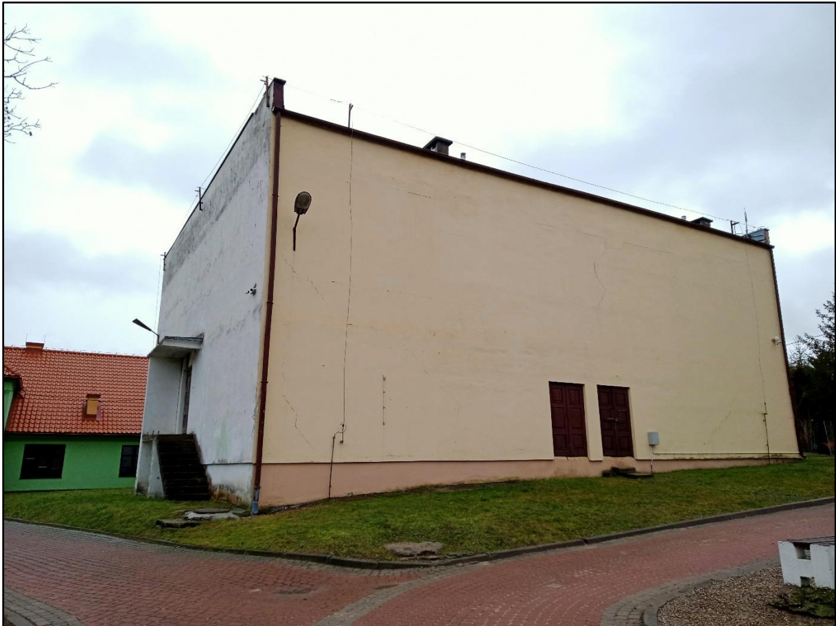
Rycina 17 Przykład przestrzeni wymagającej poprawy stanu technicznego na obszarze rewitalizacji – stare kino Źródło: materiały z wizji lokalnej.
