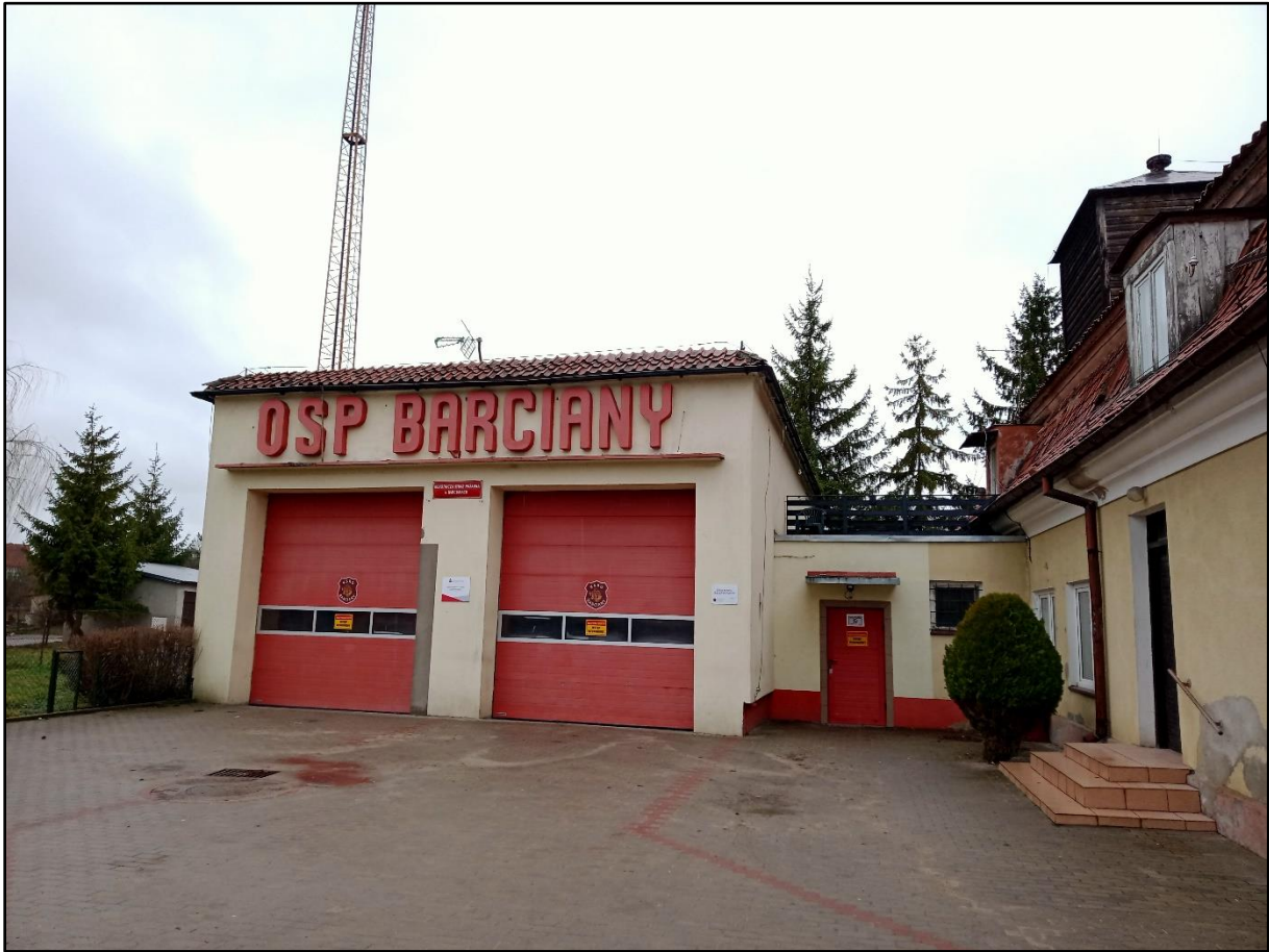
Rycina 16 Przykład przestrzeni wymagającej poprawy stanu technicznego na obszarze rewitalizacji – Ochotnicza Straż Pożarna w Barciany
